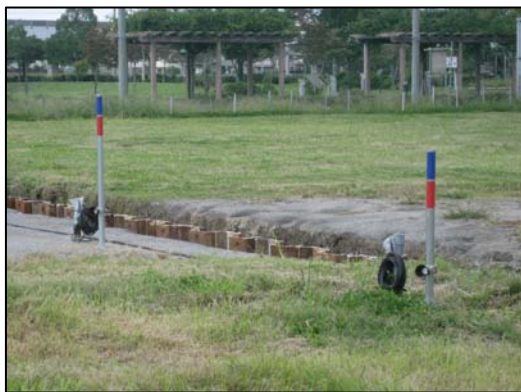
計測機器（沈下、地下水位）
