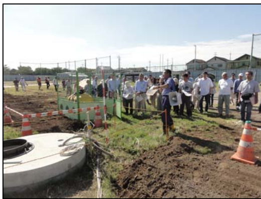
排水溝工法エリアを見学している様子
