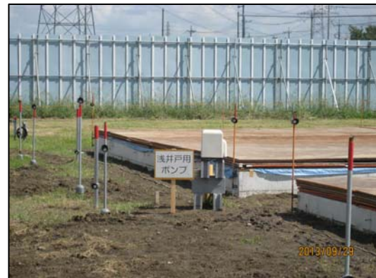
井戸工法エリアの様子
