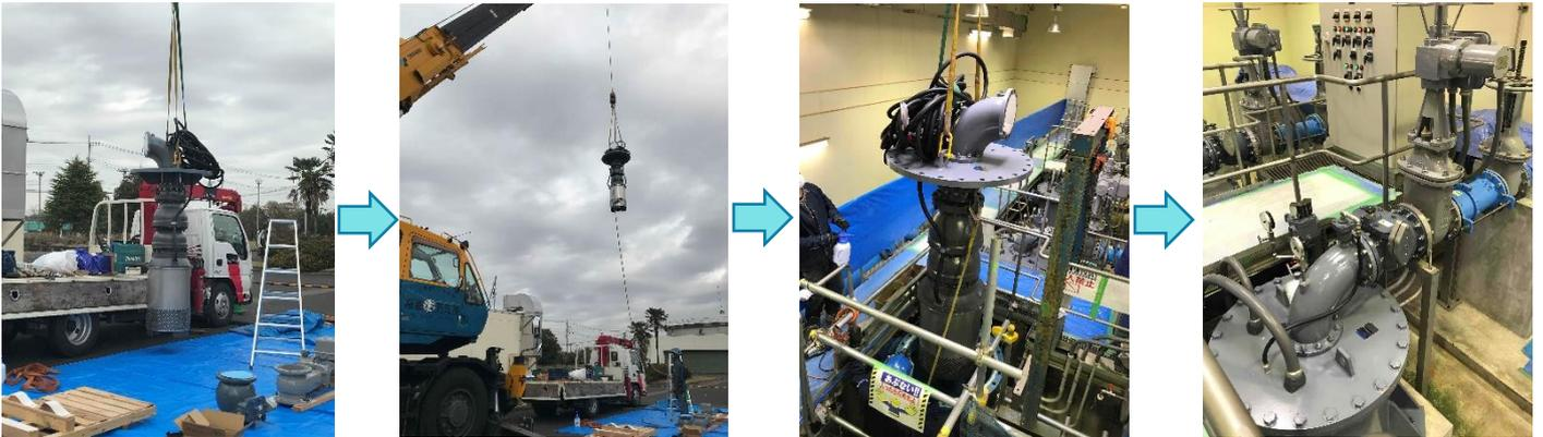
森下浄水場配水ポンプ設備更新工事の様子です。クレーンでポンプを吊り上げて交換をしました。
