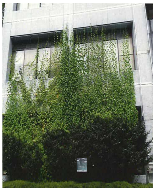
菖蒲総合支所庁舎
