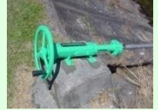
ゲート、バルブの更新
