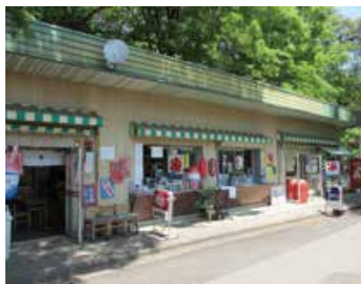
154. ポート池のほとりに建つ売店・食堂
