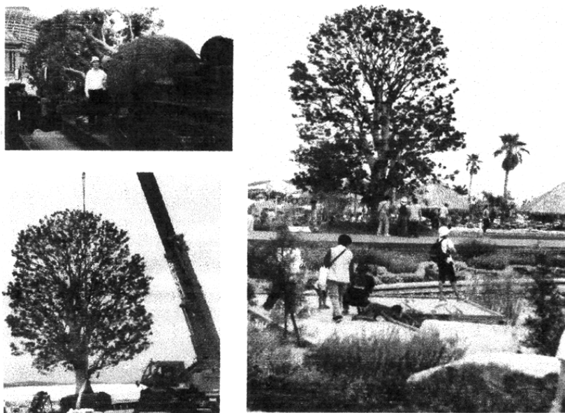
図5 ヤマモモの運搬、植付け、仕上がり 出典：改定緑化・植栽マニュアル
