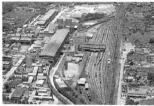
秩父セメント秩父工場
