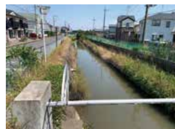
R4年度に浚渫を行う江川堀
