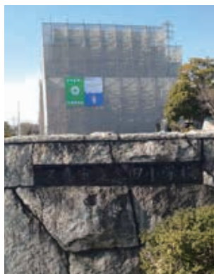
外壁改修工事中の太田小学校
