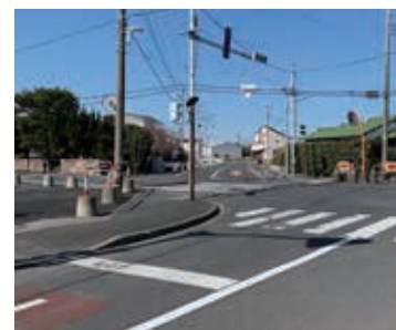
安全対策が必要な通学路の交差点
