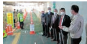
漏水の現場を視察
