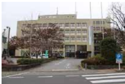
建て直し予定の市役所
