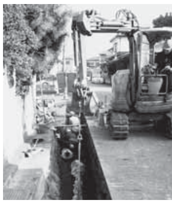
老朽管を布設替えし、耐震性のある管へ（鷺宮地区）
