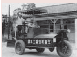
道路補修車 (昭和38年)
