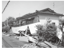
▲平成28年4月の熊本地震での木造住宅被害
