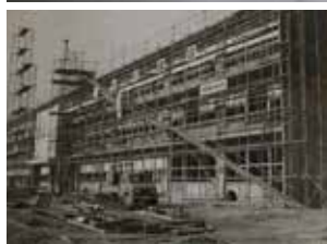
▲校舎の建築中 (昭和46年)
