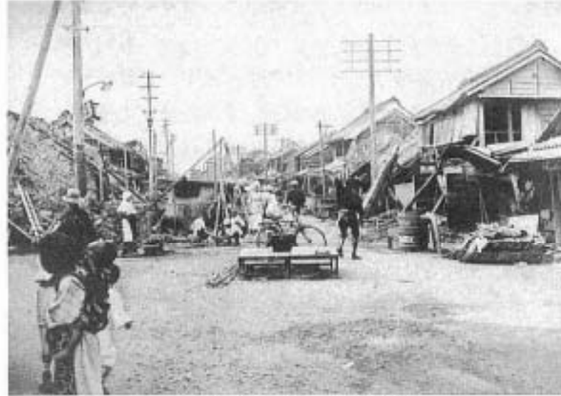
幸手町の家屋倒壊（埼玉県農業試験場）
