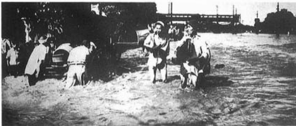
カスリーン台風による久喜駅付近の惨状（『埼玉県水害誌』より）
