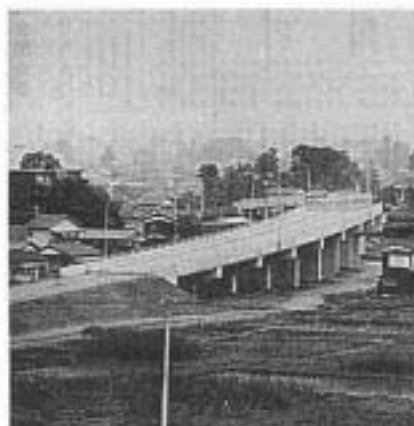
県道幸手久喜線の オーバブリッジ
