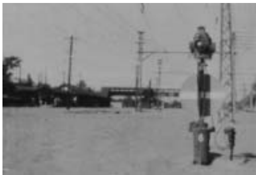
水害時の久喜駅の様子 利根川上流河川事務所提供
