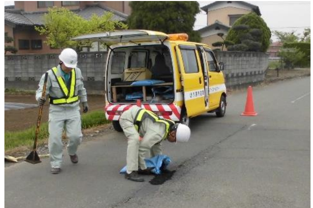
道路レスキュー 平成28年
