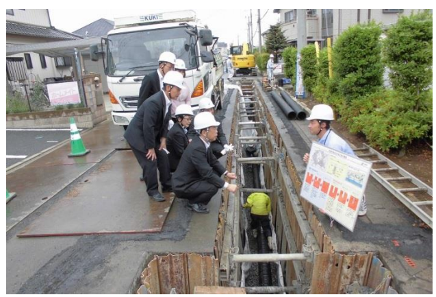
久喜市液状化対策工事 平成27年～平成29年
