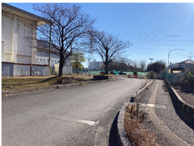
写真⑬ テニスコート側出入口
