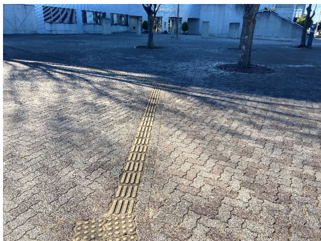
写真⑪ 第1体育館周辺の舗装
