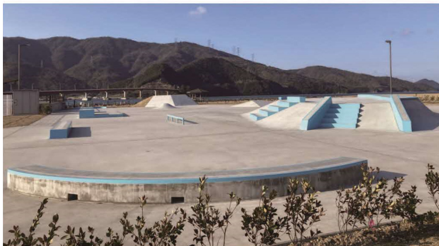
スケートボード場 イメージ(事例:福井県おおい町 成海緑地スケートパーク)
