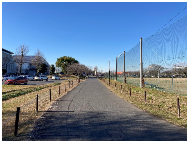
写真⑩ 主園路から第1駐車場
