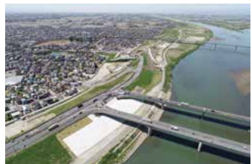
利根川堤防付近の航空写真
